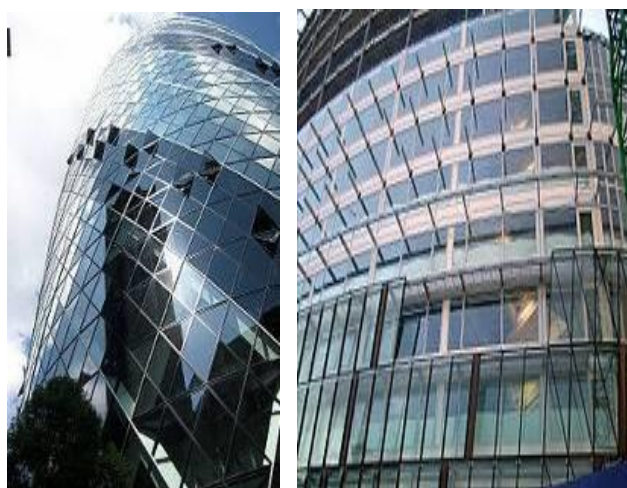
صورة (12) توضح الواجهات ذات الاغلاف المزدوج
