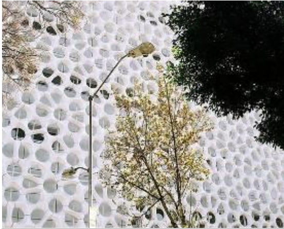
صورة (13) استخدام ثاني اكسيد التيتانيوم لتنقية الهواء من الملوثات في غلاف الواجهات
