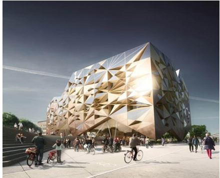
صورة (6) الواجهة كدرع واقى من اشعة الشمس ومن خلالها يولد الطاقة للمبنى
